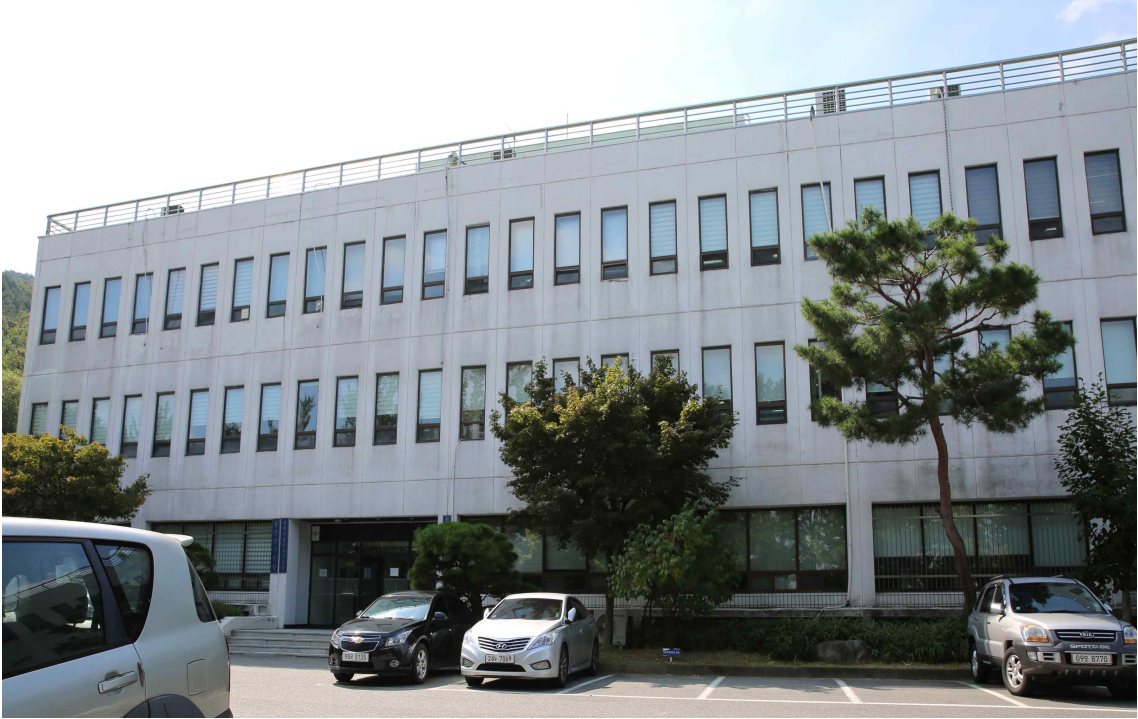
[공군본부 군사법원 청사 전면]
