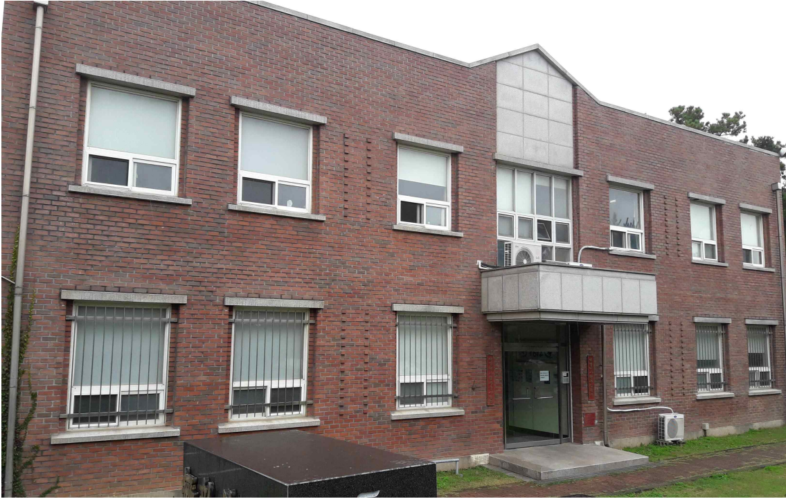
[해병사 군사법원 청사 전면]
